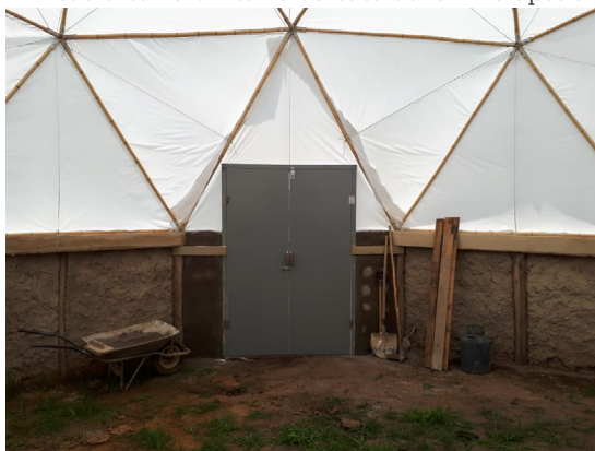
Imagens 7 – Visão externa e interna da casa de farinha após a construção
