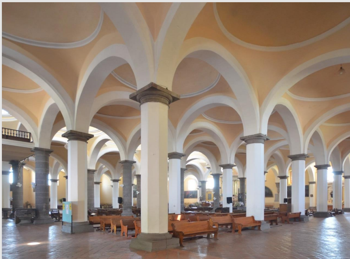
Figura 23: Capilla Real do Convento Franciscano de San Gabriel Arcángel, em Cholula, México. Imensa capela de índios claramente inspirada na arquitetura de mesquitas, como a de Córdoba – com suas 49 cúpulas sustentadas por inúmeros pilares e colunas. Segunda metade do século XVI.
