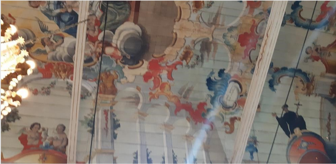
Figura 2. Forro Nave. Matriz de Santo Antônio, Ouro Branco. – Arquivo Pessoal.
