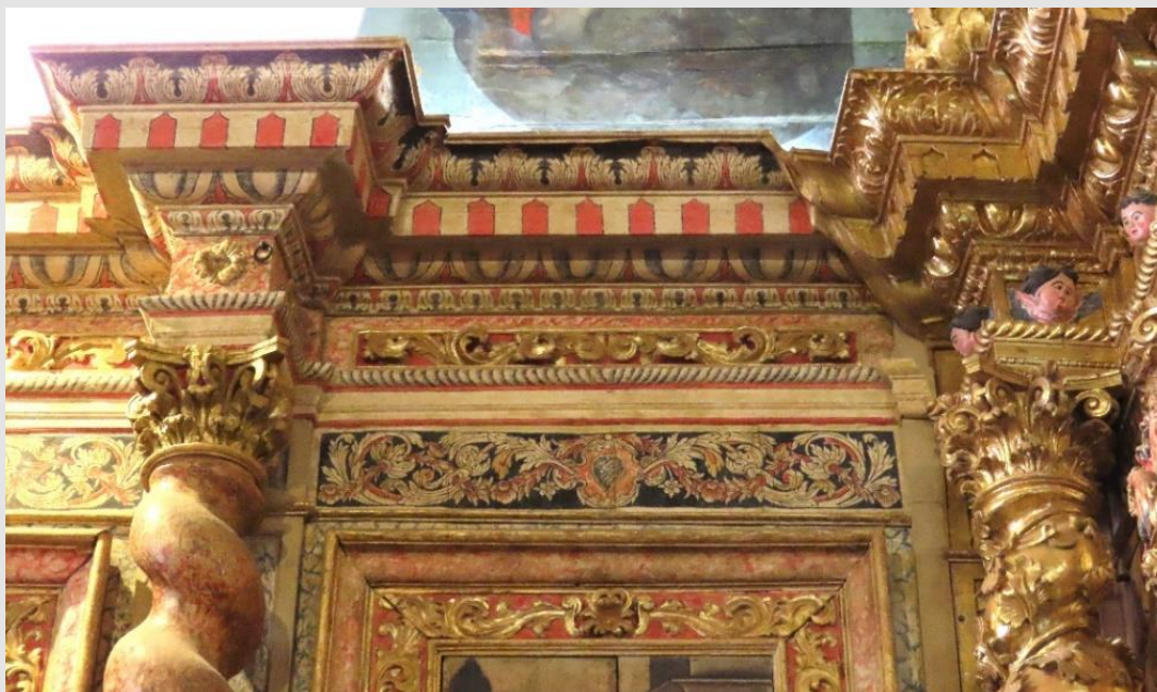
Figura 6. Aspecto da ornamentação das ilargas da capela-mor da Matriz de Nossa Senhora de Nazaré, Cachoeira do Campo, Ouro Preto-MG, século XVIII. Embutidos marmóreos pintados e fingidos pétreos. Fotografia: Luiz Cruz, 2023.
