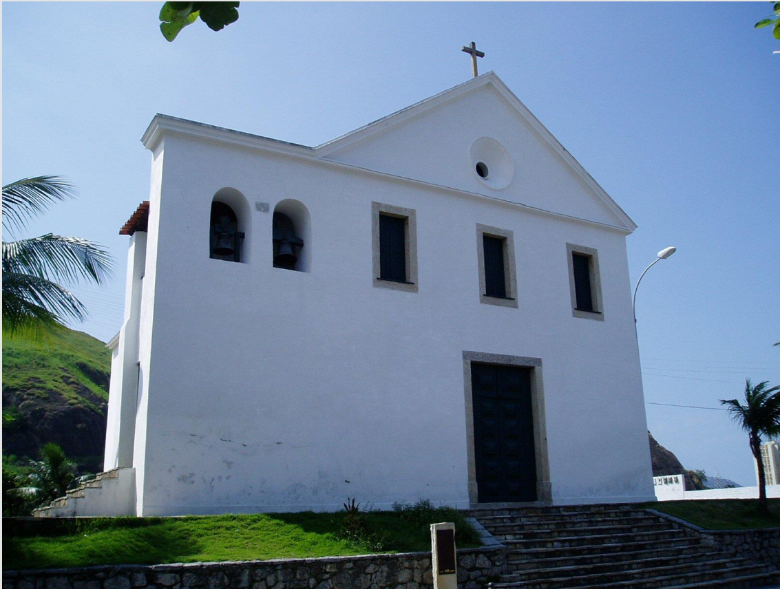
Figura 3. Igreja de São Lourenço dos Índios de Niterói – fachada – foto do autor
