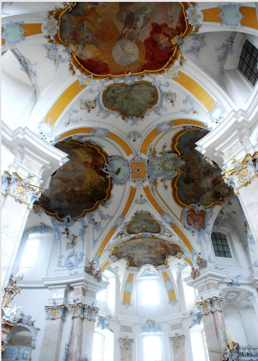
Figura 18: O cruzeiro do Santuário de Vierzehnheiligen foi reduzido a um ponto de interseção entre quatro abóbadas – duas estruturas elípticas oriundas da nave longitudinal e duas cúpulas hemisféricas conformadoras dos transeptos. Fotografia elaborada pelo autor, 2012.
