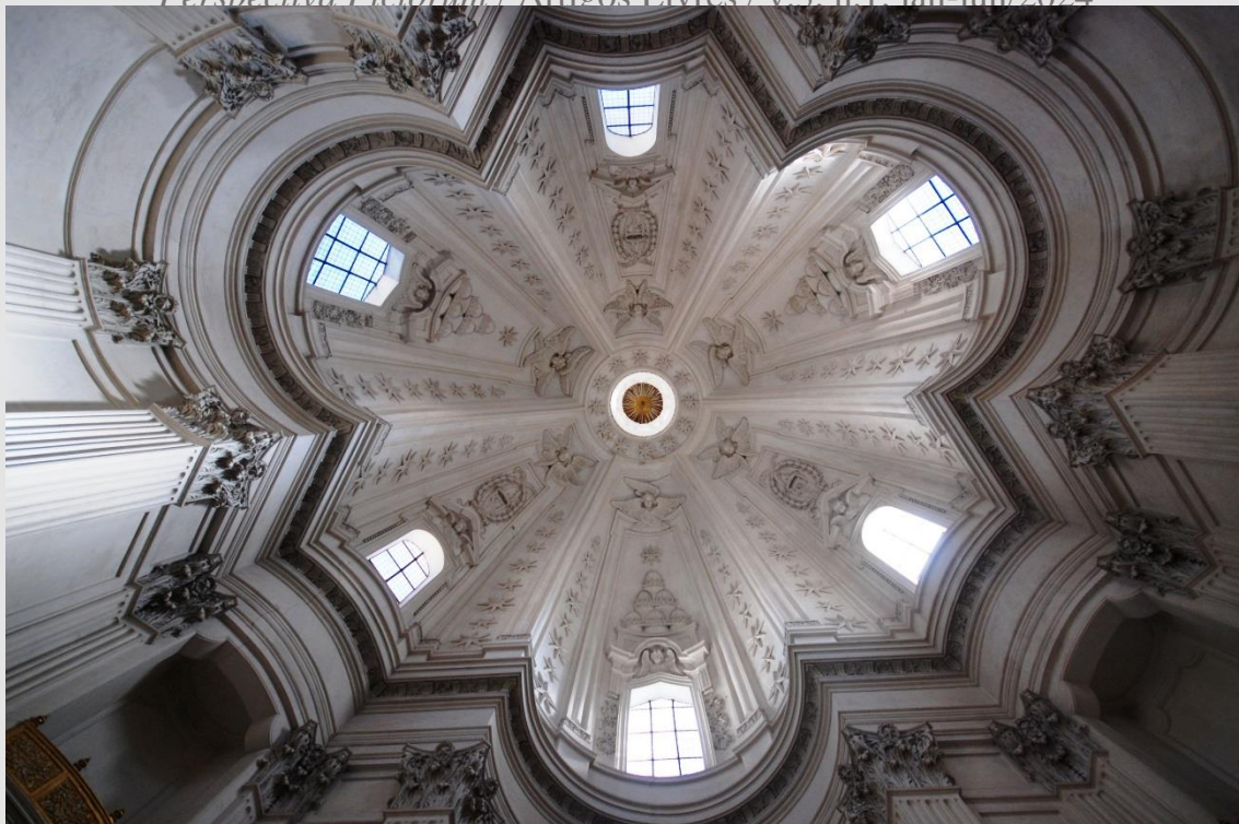
Figura 9: Interior da Igreja de Sant'Ivo alla Sapienza. A calota da cúpula acolhe a complexa interpenetração de estruturas côncavas e convexas. Fotografia elaborada pelo autor, 2007.
