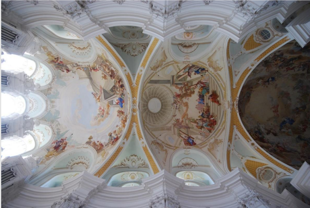
Figura 15: Detalhe das cúpulas elípticas com seus arcos de dupla curvatura de sustentação, formando a abóbada da Igreja de Neresheim. Fotografia elaborada pelo autor, 2012.
