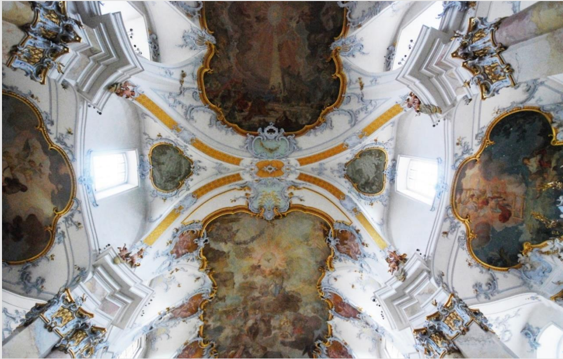
Figura 17: Detalhe das cúpulas elípticas com seus arcos de dupla curvatura de sustentação formando a abóbada da Igreja do Santuário de Vierzehnheiligen (Quatorze Santos). Fotografia elaborada pelo autor, 2012.
