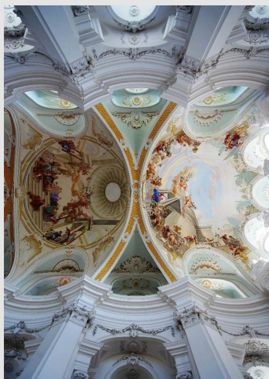
Figura 13: Detalhe das cúpulas elípticas com seus arcos de dupla curvatura de sustentação. Fotografia elaborada pelo autor, 2012.
