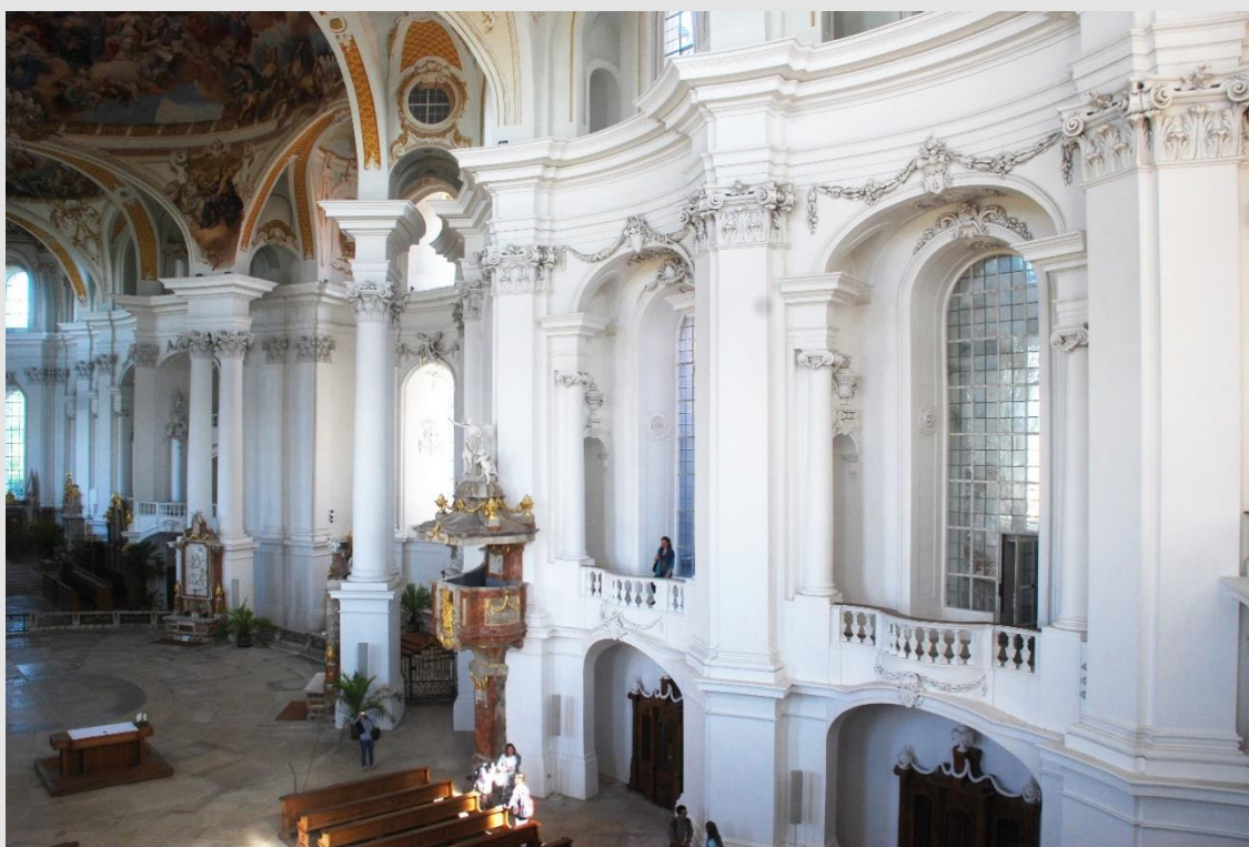
Figura 14: Detalhe dos pilares de sustentação da abóbada da Igreja de Neresheim. Devido ao uso dos arcos estruturais de dupla curvatura é possível perceber como os apoios estruturais não conformam uma sequência linear de pilares, mas modelam os sucessivos espaços elípticos que comporiam o interior do edifício. Fotografia elaborada pelo autor, 2012.
