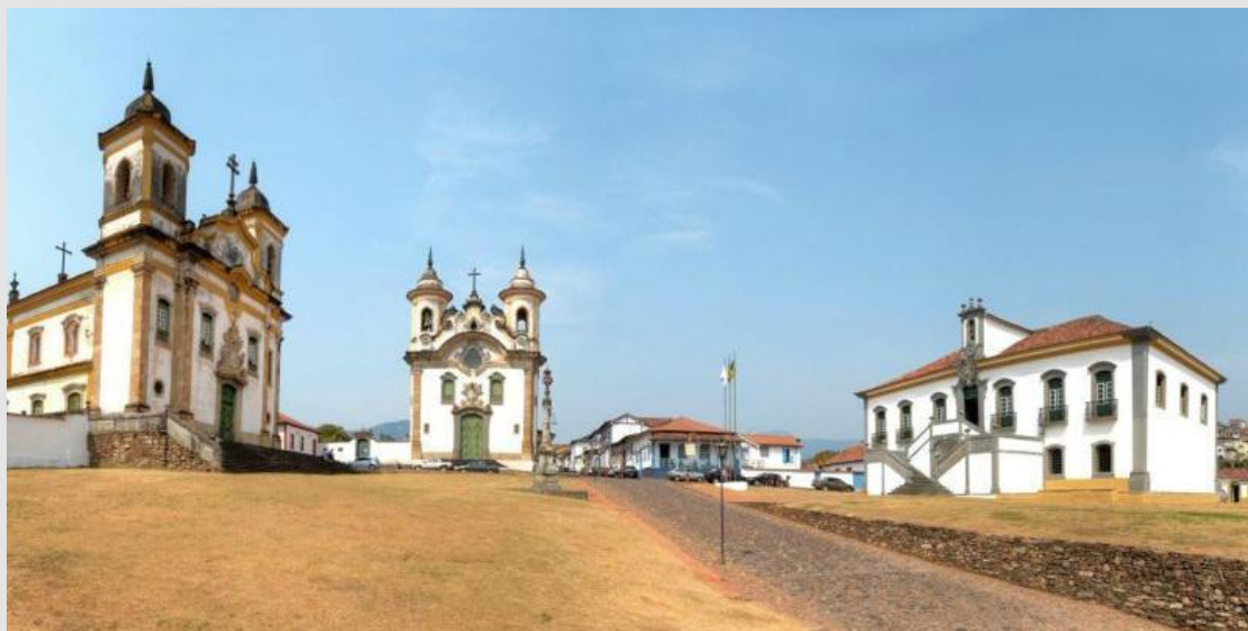
Figura 2: Igreja da Ordem Terceira de São Francisco de Assis, igreja da Ordem terceira de Nossa Senhora do Carmo e Casa de Câmara e Cadeia, Mariana, MG. Três importantes edificações que mobilizaram vastos canteiros de obras ao longo do século XVIII Fonte: Disponível em https://www.hojeemdia.com.br/minas/predio-tombado-da-camara-de-mariana-sera-restaurado-e-ampliado-1.80925
