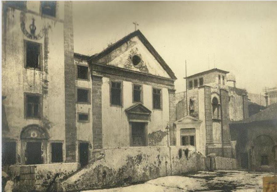
Figura 3 – Fotografia da Igreja do Colégio do Rio de Janeiro (anterior à demolição).
