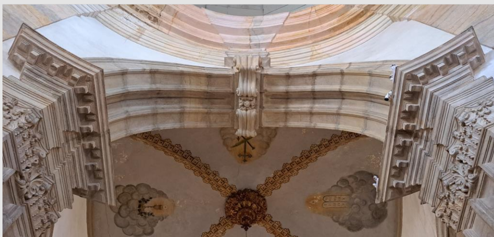
Figura 27: Arco do cruzeiro de dupla curvatura. Marca a interpenetração dos espaços ovalados da nave e da capela-mor do Rosário. Fotografia elaborada pelo autor, 2024.
