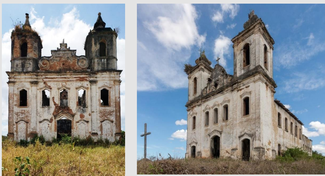
Figura 18. Fachada da Capela de Nossa Senhora de Nazaré do Engenho Itaperoá, na zona rural de São Cristóvão, Sergipe (à esquerda) e Capela de Nossa Senhora da Conceição do antigo Engenho Penha, em Riachuelo, Sergipe (à direita). Fonte: Fotografias de Reginaldo Pina Neto, 2020.
