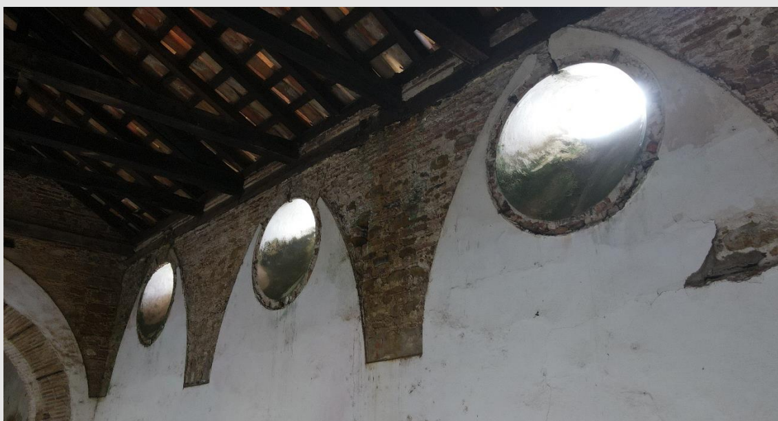
Figura 26. Detalhe do alto de uma das paredes laterais da capela-mor. Os contornos rebocados da parede – abertos com óculos circulares, em contraste com a alvenaria bruta ao lado – revelam as marcações de onde chegavam as lunetas ogivais que perfuravam a antiga abóbada de berço falsa de madeira, que cobria o ambiente do presbitério – forro hoje perdido. Fonte: Imagem de drone capturada por Lucas Alves Ribeiro, 2024.
