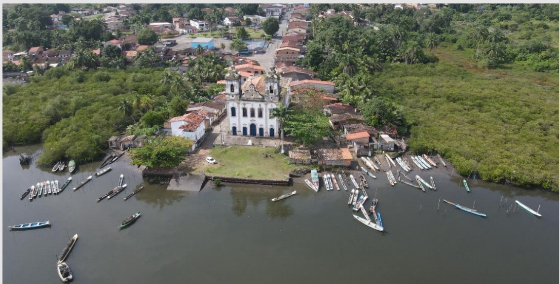
Figura 3: Foto área da Freguesia de Santiago do Iguape na qual se destaca a monumental igreja paroquial na borda d'água, voltada de frente para a Baía do Iguape. Fonte: Imagem de drone capturada por Lucas Alves Ribeiro, 2024.
