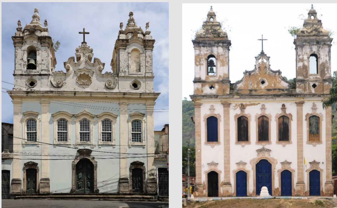
Figura 15. Comparativo entre as fachadas da Igreja do Ordem Terceira de Nossa Senhora da Conceição do Boqueirão de Salvador (à esquerda), e da Matriz de Santiago do Iguape (à direita). As proporções da Igreja do Iguape são ainda mais harmônicas e equilibradas que as do Boqueirão.
