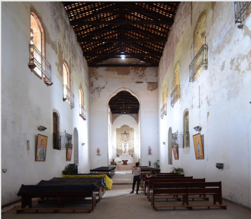
Figura 25. Nave e capela-mor da Matriz de Santiago do Iguape, quase totalmente desprovidas dos bens integrados, gradativamente arruinados ou saqueados: altar-mor, retábulos do cruzeiro e retábulos laterais, púlpitos, coro, etc – todos elementos desaparecidos. Destaque para o arco do cruzeiro trilobado, solução bastante incomum na arquitetura religiosa brasileira. Fonte: Fotografia de Rodrigo Baeta, 2025.
