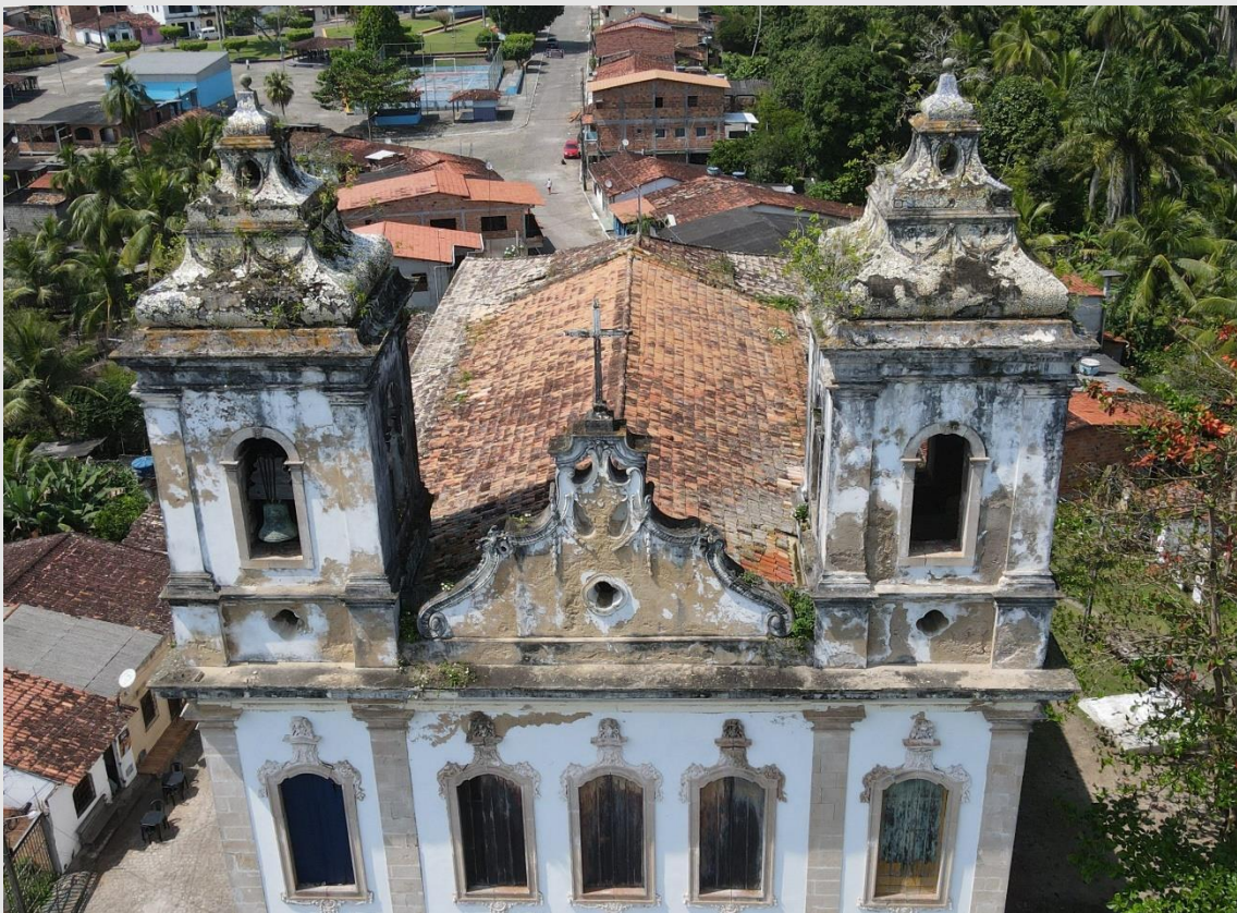
Figura 22. Detalhes do arremate das torres (com cobertura bulbosa) e do frontão da Igreja Matriz de Santiago do Iguape. Fonte: Imagem de drone capturada por Lucas Alves Ribeiro, 2024.
