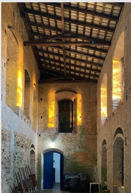
Figura 28. Sala lateral direita. Corredor lateral mais largo que acompanha a capela-mor. Percebe-se a ausência completa de reboco, expondo a alvenaria bruta. Também é possível notar a perda do piso das tribunas.
