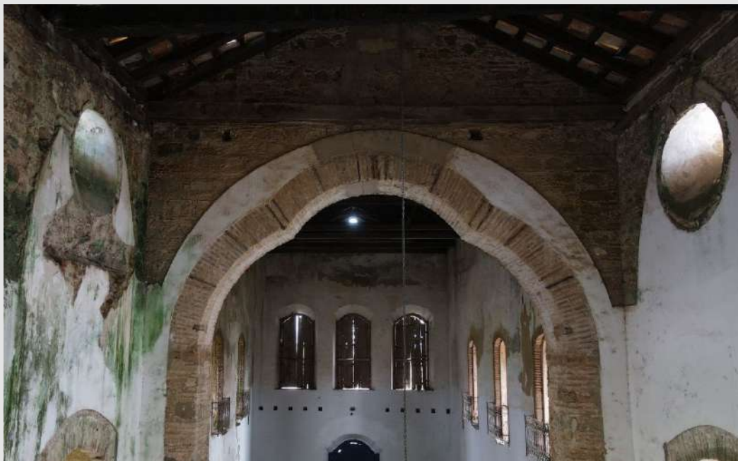
Figura 27. Fotografia elevada de drone, voltada para o fundo da igreja, mostrando: o arco do cruzeiro trilobado, sem seu acabamento de pedra ou de madeira; ao fundo, a ausência do coro, com destaque para a marcação de sua antiga estrutura abaixo das três janelas do frontispício que se abriam ao coro; acima, na capela-mor, nota-se as marcações das lunetas oriundas da antiga abóbada de madeira, bem como os vãos circulares dos óculos. Fonte: Imagem de drone capturada por Lucas Alves Ribeiro, 2024.
