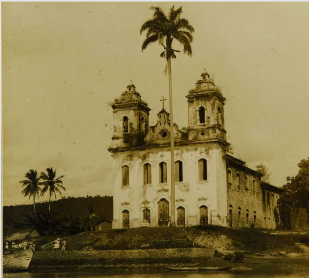
Figura 23: Fotografia do acervo do IPHAN (1958) mostrando a Igreja Matriz de Santiago do Iguape com sua fachada principal rebocada, mas sua fachada lateral direita sem acabamento. Na verdade, as fachadas laterais e de fundo, até pouco tempo, expunham toda a alvenaria portante em seu estado bruto, nunca tendo sido rebocadas e pintadas. Fonte: Acervo do IPHAN, 1958.
