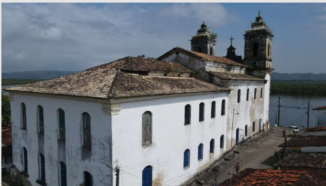
Figura 24: Em 1982 o IPHAN autorizou obras de revestimentos das fachadas – decisão que nos parece equivocada: historicamente as fachadas nunca haviam sido rebocadas, outro aspecto interessante e singular do templo. Esta fotografia mostra a fachada lateral esquerda com seu acabamento e pintura – já bastante desgastados na altura dos corredores laterais. Fonte: Imagem de drone capturada por Lucas Alves Ribeiro, 2024.
