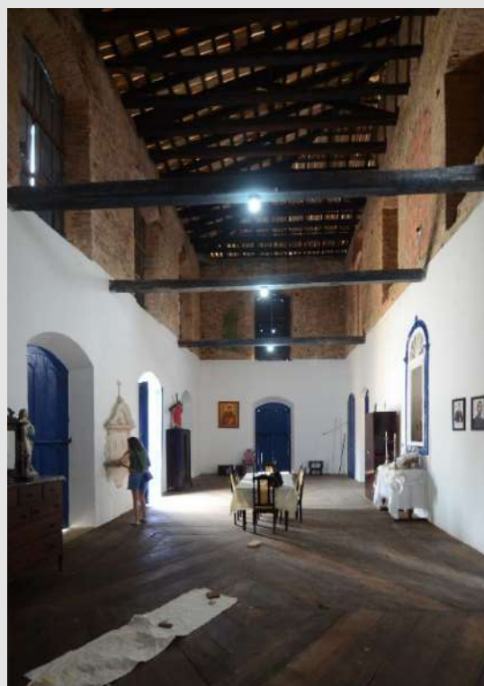
Figura 29. Sacristia. É possível notar, no pé-direito duplo do espaço, a perda do piso da sala do consistório – nível que aparece em alvenaria bruta (sem reboco). Fonte: Fotografia de Rodrigo Baeta, 2025
