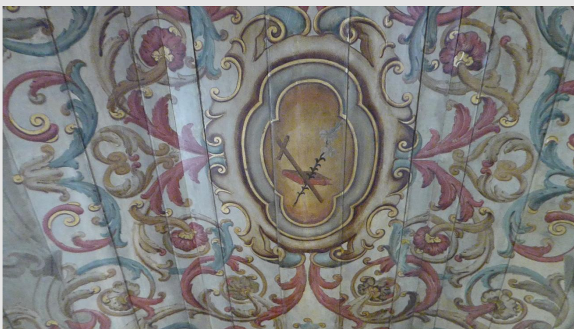
Figura 7 - Forro da Capela-mor. Capela de Santo Antonio, São Roque. Foto: Victor Hugo Mori
