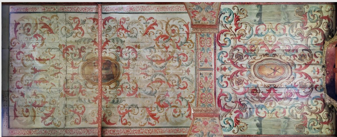
Figura 6 - Forro da nave e capela mor. Capela de Santo Antônio, São Roque. Foto e montagem: Victor Hugo Mori
