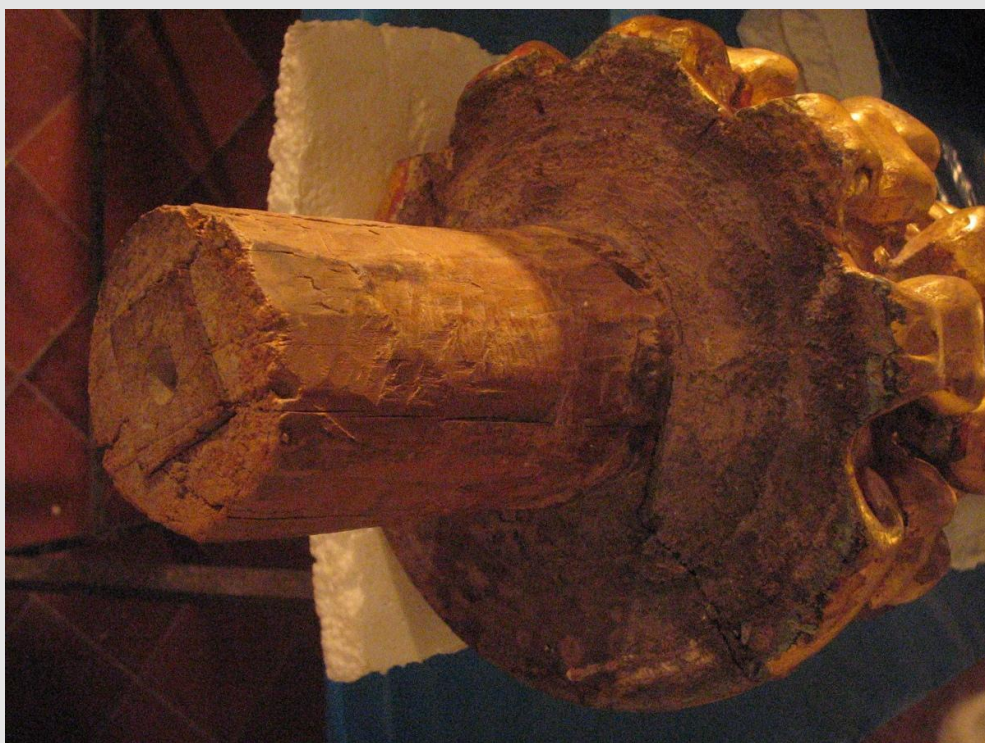
Figura 5. Detalle de punta de torno en la espiga de la columna del retablo de San José, Santiago Tejupan, Oaxaca. Primer tercio del siglo XVII. Foto: Luis Huidobro, 2006.
