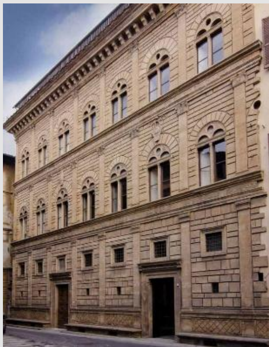
Fig. 2. Palazzo Rucellai di L.B. Alberti /1450)
