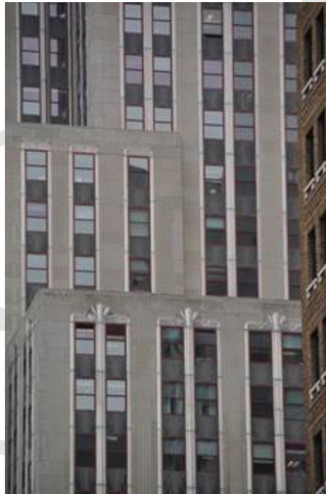
Fig. 9. Escalonamento da fachada do edifício Empire State (1931), em Nova York, o que motivou um dos nomes do estilo na época, "zigzag style". Fotografia do autor.
