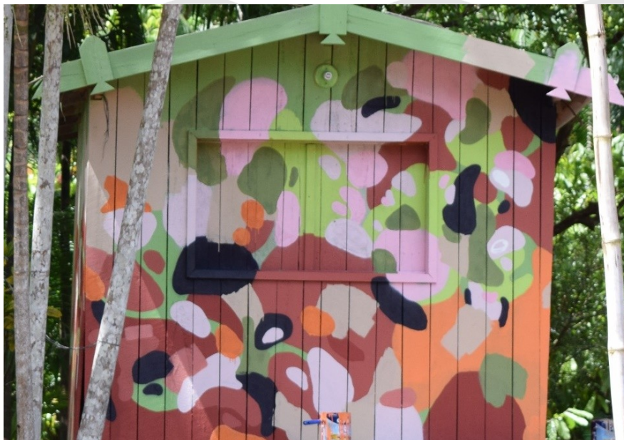
Figura 4. Justaposição das tábuas com as interseções na vertical em estabelecimento no Igarapé do Combu. Fonte: Teixeira (2018c).
