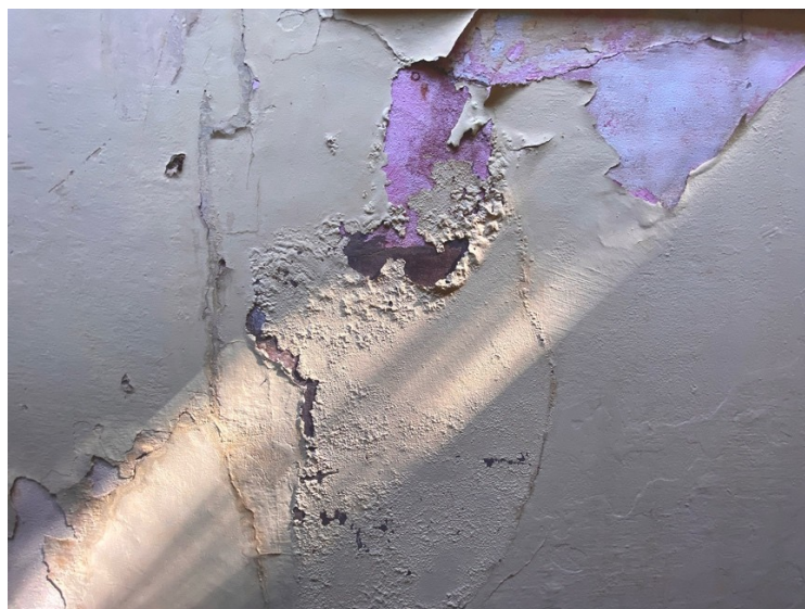
Figura 1. Detalhe de parede no Centro Cultural Casarão, 2024. Fotografia: Carolina Peres.
