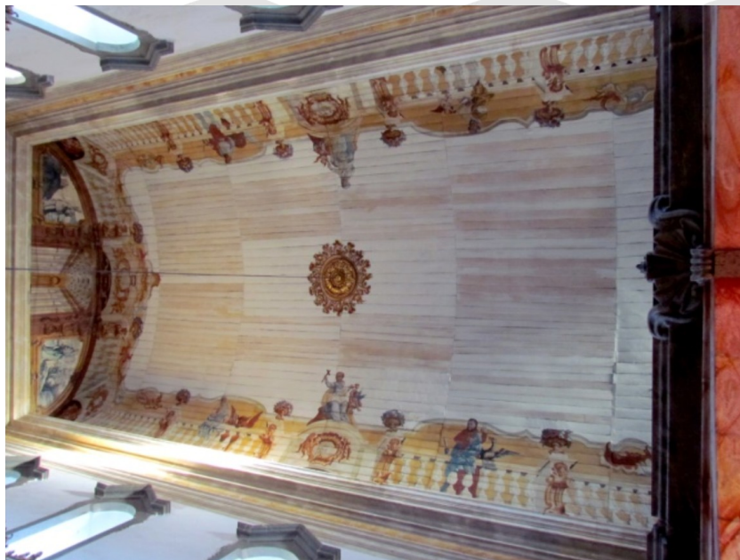
Fig. 2 – Forro da nave da igreja Matriz de Nossa Senhora do Bom Sucesso, em Caeté, 2016. Fonte: Fotografia do autor.
