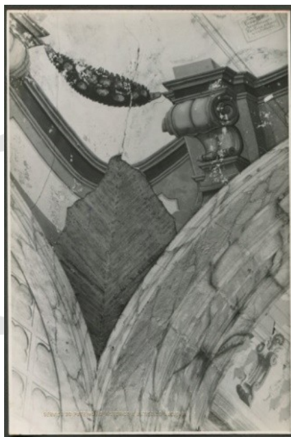
Fig. 1. – Detalhe estuque danificado da capela-mor, Matriz de Nossa Senhora do Bom Sucesso, c. 1943.
