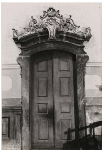
Fig. 4 – Detalhe ilharga da capela-mor, Matriz de Nossa Senhora do Bom Sucesso, c. 1943. Fonte: Arquivo Central do Instituto do Patrimônio Histórico e Artístico Nacional, Seção Rio de Janeiro (ACI-RJ), F010589.
