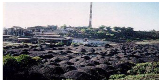
Figura 5: Pátio da mineradora PLUMBUM/COBRAC em Santo Amaro: aterro formado por amontoados de escória de chumbo dispostos sobre o solo e a céu aberto. Fonte: Imagens arquivadas ao relatório do estudo conduzido pela Secretaria da Saúde da Bahia, (SESAB, 2013).
