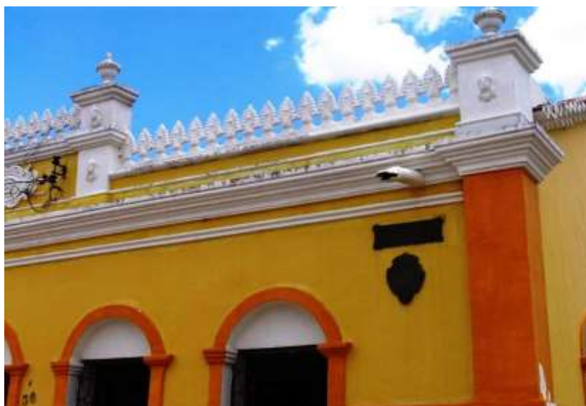
Imagem 1: Platibanda na residência de Antônio da França Cardoso 1
