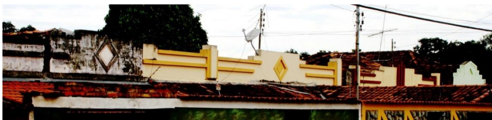
Figura 12: SETOR 06: Casario da “rua dos Hotéis” /Benedito Valadares, fachadas originais com varandas construídas na década de 1990
