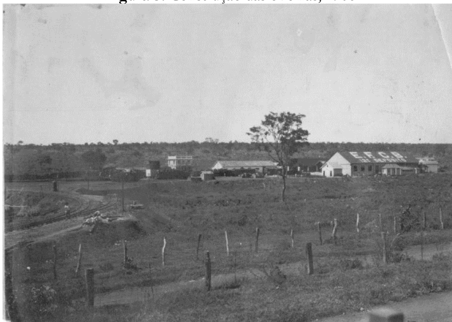
Figura 3: Construção das oficinas, 1906
