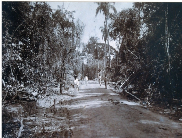
Figura 9 - Estrada de rodagem construída pela Municipalidade de Marabá – década de 1920.
