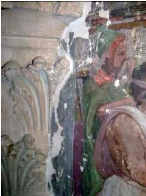
15. Fissuras devidas ao movimento de ajuste estrutural do edifício. Foto U.I.A..
