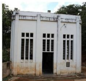
Prédio da Usina Hidroelétrica. Séc. XX. Foto: Leandro Rezende.
