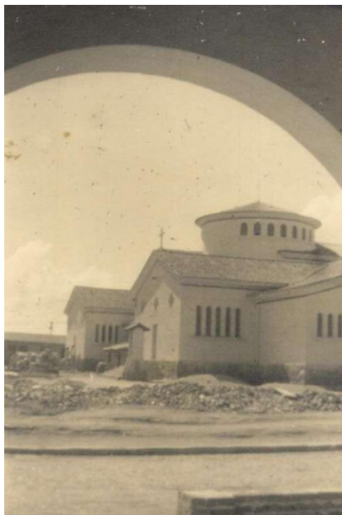
Figura 2. Construção da Igreja
