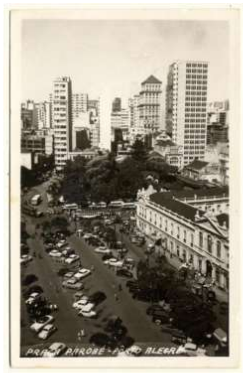
Vista do estacionamento instalado no local da praça arborizada.
