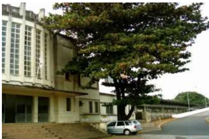
Imagem 4: vista da estação em 2009, com o início do viaduto.
