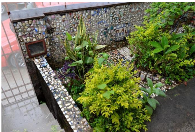
Figura 1 - Muro no bairro Carlos Prates Foto: Gilson Rodrigues, 2013.
