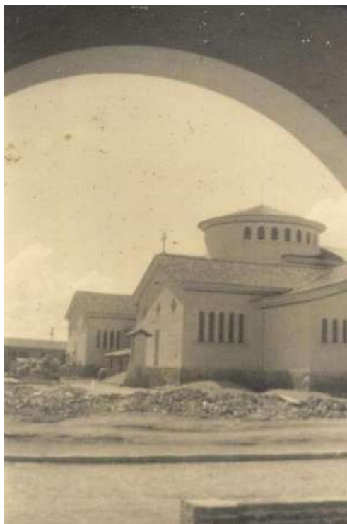
Figura 2. Construção da Igreja
