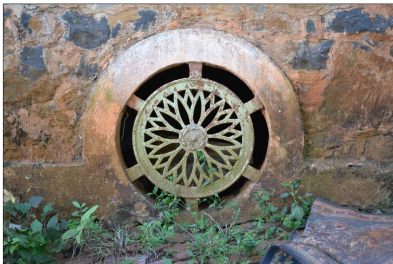
Figura 8: Detalhe de vão circular para ventilação do porão, com grades de metal e motivo decorativo com referências ao café. Fotografias de Luciana A. S. Machado.
