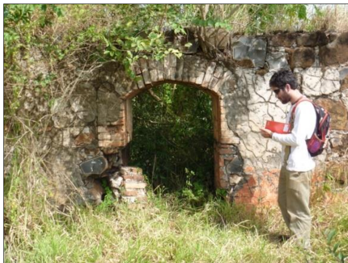
Figura 10: Sítio Fazenda São João da Senzala. Ruínas da possível senzala, com vista externa de vão de entrada com acabamento em tijolos, indicando uma modificação posterior à da edificação com blocos de basalto. Fotografias de Fabio G. Almeida
