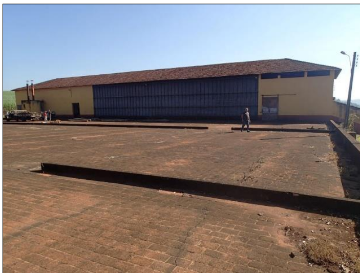
Figura 13: Fazenda Tibiriçá - Terreiro de secagem, tulha e casa de máquinas.
