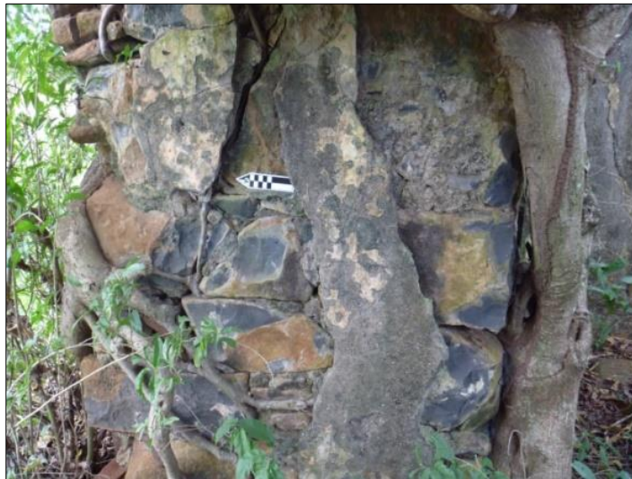
Figura 9: Sítio Fazenda São João da Senzala. Detalhe da estrutura de fundação da possível senzala, com mais de um metro de espessura, edificada com blocos de rocha basáltica.
