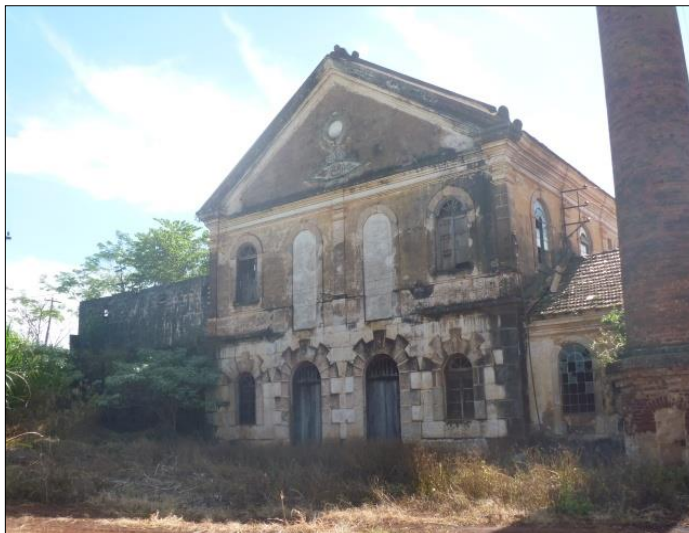
Figura 4: Fazenda Santa Olympia - vista frontal do pavilhão principal. À esquerda, muro de pedras do terreiro de café.
