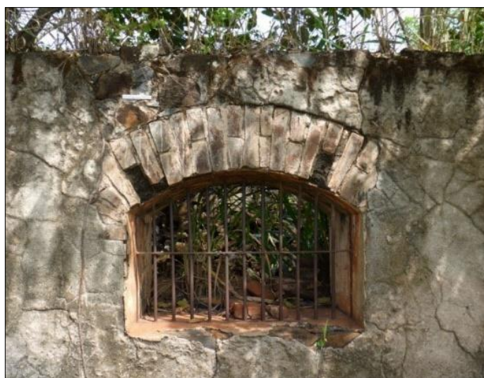
Figura 11: Detalhe de janela gradeada com metal e arco com tijolos. Fotografia de Fabio G. Almeida.
