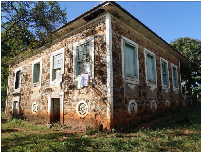
Figura 7: Parte da edificação da casa sede feita de alvenaria de pedras.
