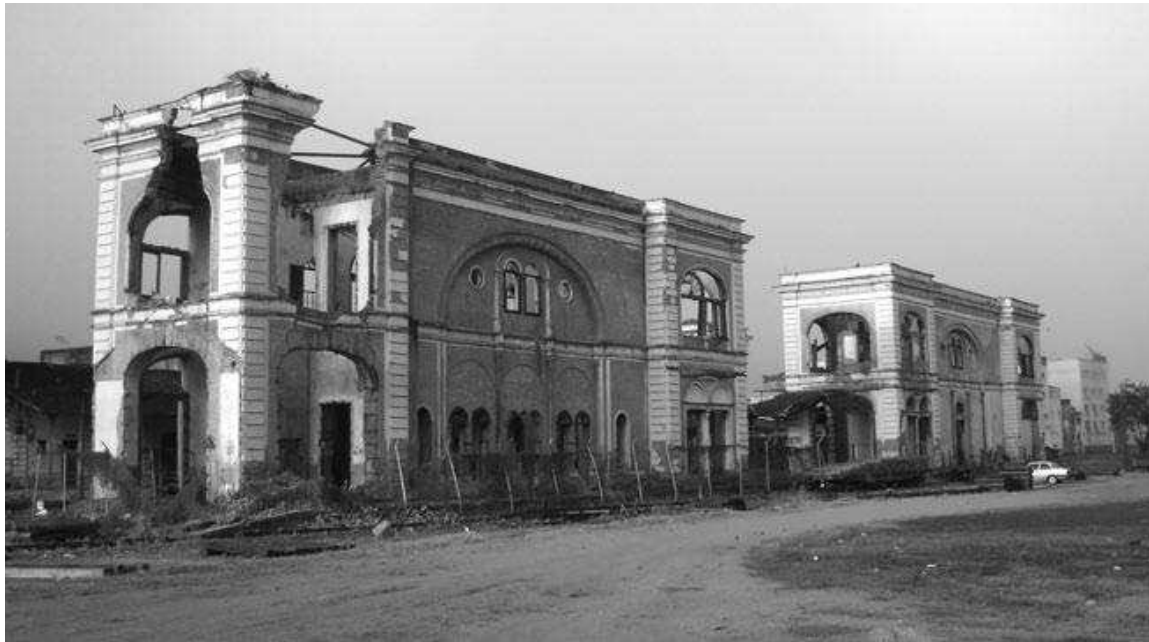
Figura 19: Estação Porto Novo do Cunha – Município de Além Paraíba (MG). Fonte: Laboratório de Arqueologia da Fafich/UFMG.
