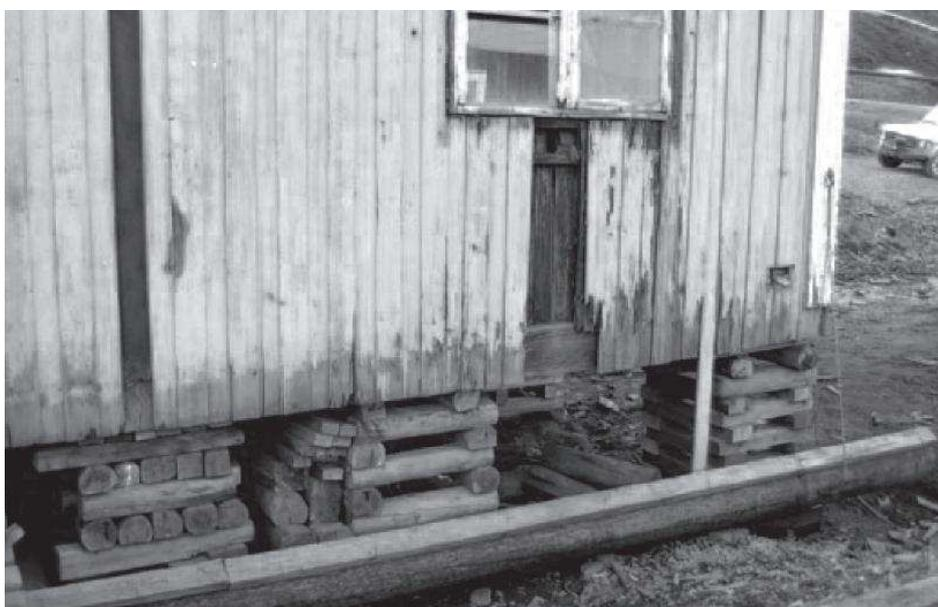
*A base de uma edificação em Svalbard apodreceu pelo contato com o solo. Ela foi então suspensa, antes da substituição da madeira apodrecida por novos materiais. Foto: Susan Barr.*
