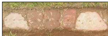
Figura 04a/04b: Alicerce com piques e baldrame de pedra - Casas do Ipê Amarelo (Alto rio das Velhas/Piranga)
