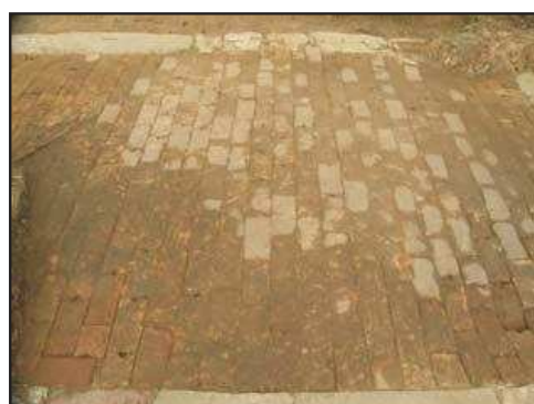
Figura 27a/27b: Piso de tijolos (Casas do Ipê Amarelo) – Alto rio das Velhas/Piranga
