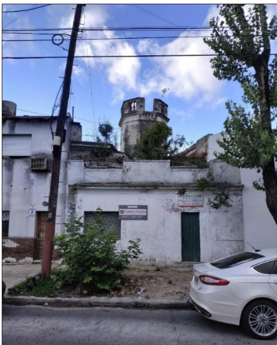
Figura 2. Vista de frente de los restos de la chacra. Calle Presidente Quintana 591. Fotografía de Archivo Personal, 15/03/2019.
