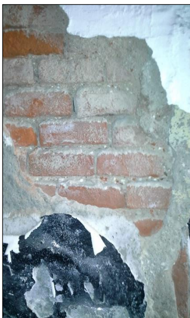
Figura 7. Muros de ladrillo expuestos dentro del taller de carenados de vehículos (Archivo Personal 16/08/2018).
