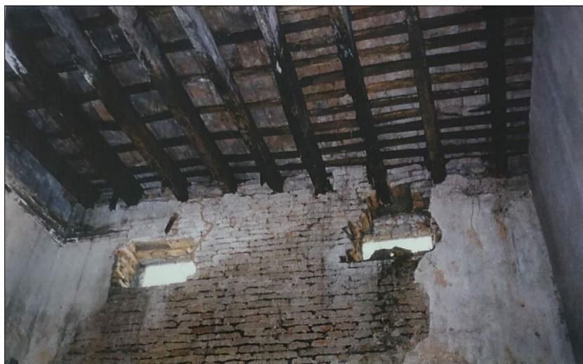
Figura 4. Vista interior del techo y muros de la casa. Fuente: Inmobiliaria Gómez Lama.
