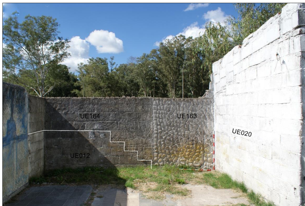
Figura 7. Vista de la esquina norte del conjunto arquitectónico antes de la excavación, en donde se señala el trazado de los escalones y suelo de la garita de vigilancia, a partir de los negativos observados en los distintos tipos de revocos. Obsérvense los suelos de baldosas de los baños y los distintos tipos de revocos de los muros. Fuente: Elaboración propia.
