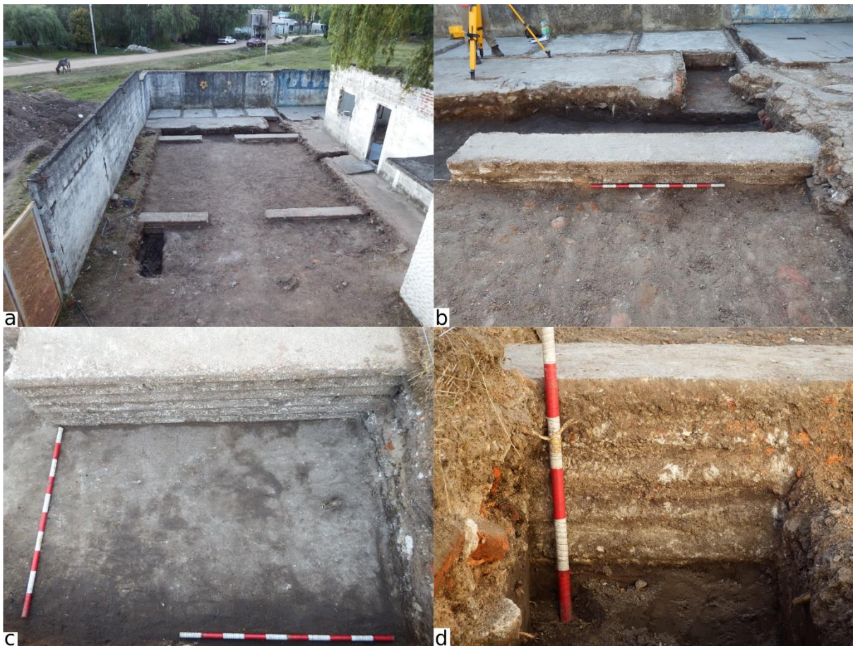
Figura 6. Diferentes vistas y detalles de los patines de hormigón documentados en el Patio Norte del ex CCDyT Los Vagones del Barrio Olímpico, que sirvieron de sustentación para dos vagones de carga. Fuente: Elaboración propia.
