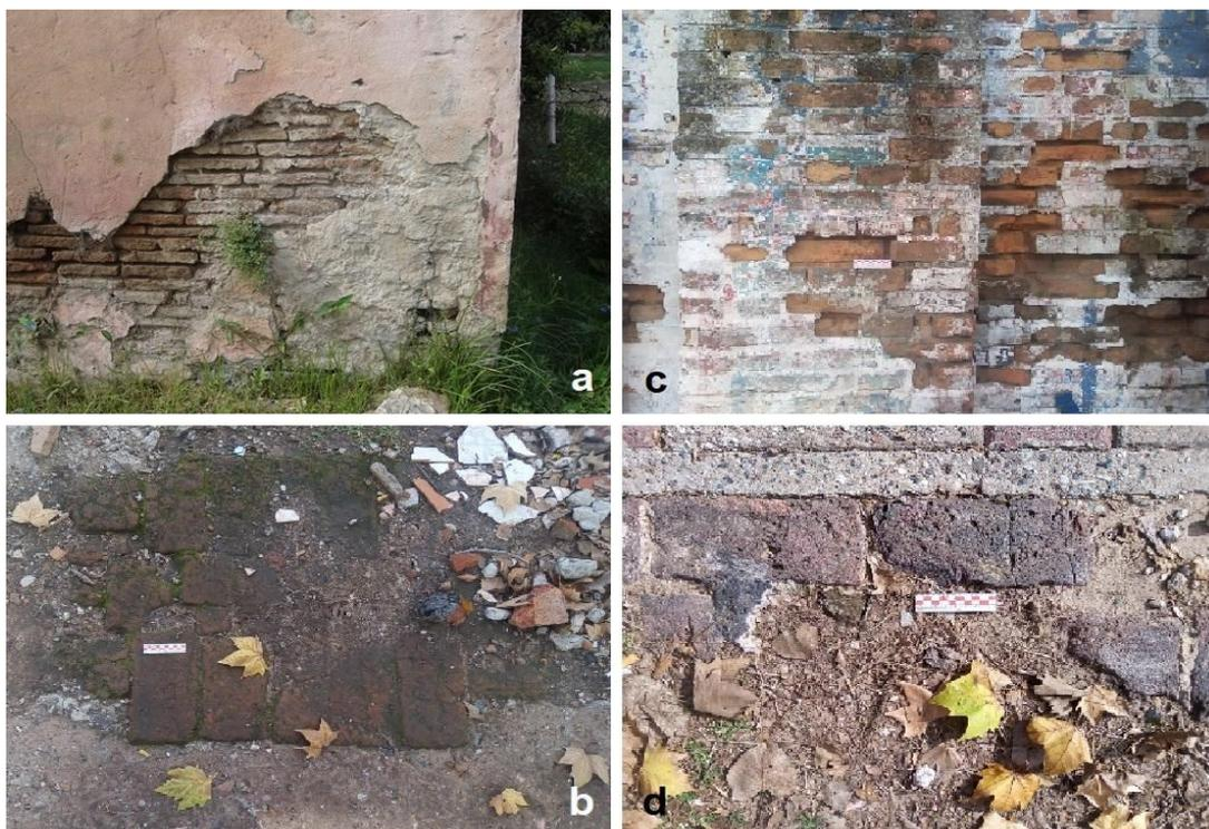
Figura 3 – a- muro norte de la “Casa Rosa” con ladrillos puestos “de sogá”, 40 x 20 x 5 cm. (c. 1870, Rocchietti, Simonassi & Gergolet, 2008). b- cimientos en Talleres Ferrocarril Central Argentino, 26 x 15 x 6 (c. 1880, Pifferetti, 2017). c- Ladrillos “bayos” en el mismo sitio Talleres, 26 x 13 x 6. d- Ladrillos “recocidos” en el mismo sitio Talleres, 24 x 12 x 6. Fotos del autor.
