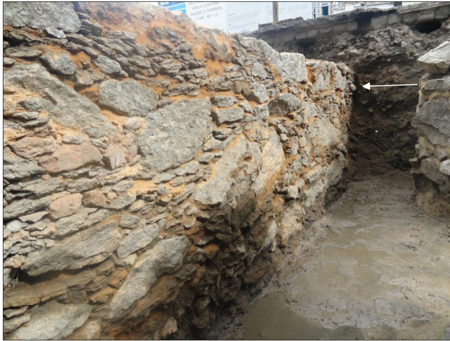
Figura 3. Localização do seixo de quartzo no alicerce de alvenaria de pedra e argamassa de cal e areia. Fotografia: Andrea Jundi Morgado (2012).
