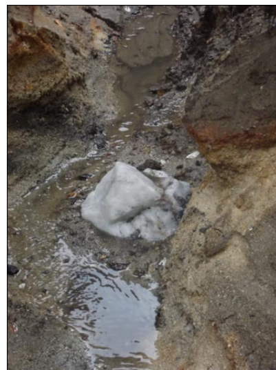
Figura 5. Durante a escavação, o achado de um grande bloco de quartzo entre duas robustas sapatas de alvenaria de pedra. Ao lado, detalhe da pedra em meio ao lençol freático, cuja água foi previamente bombeada e drenada pelas mangueiras azuis. Fotografia: Andrea Jundi Morgado (2012).
