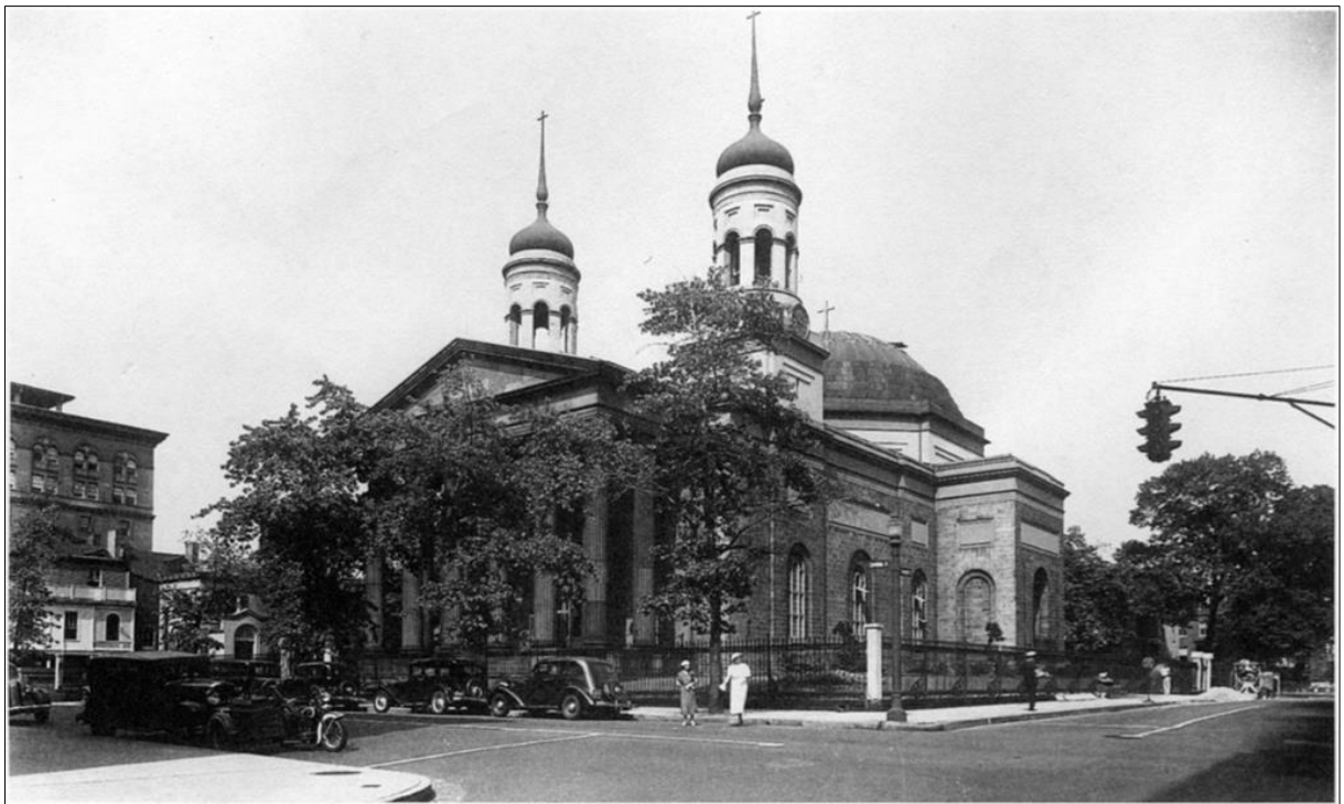
Figura 3. Exterior de la catedral Católica Romana de Benjamin LaTrobe en Baltimore (1808-21). Cortesía de HABS, Biblioteca del Congreso [HABS MD 4-BALT 41-1 MD186].
