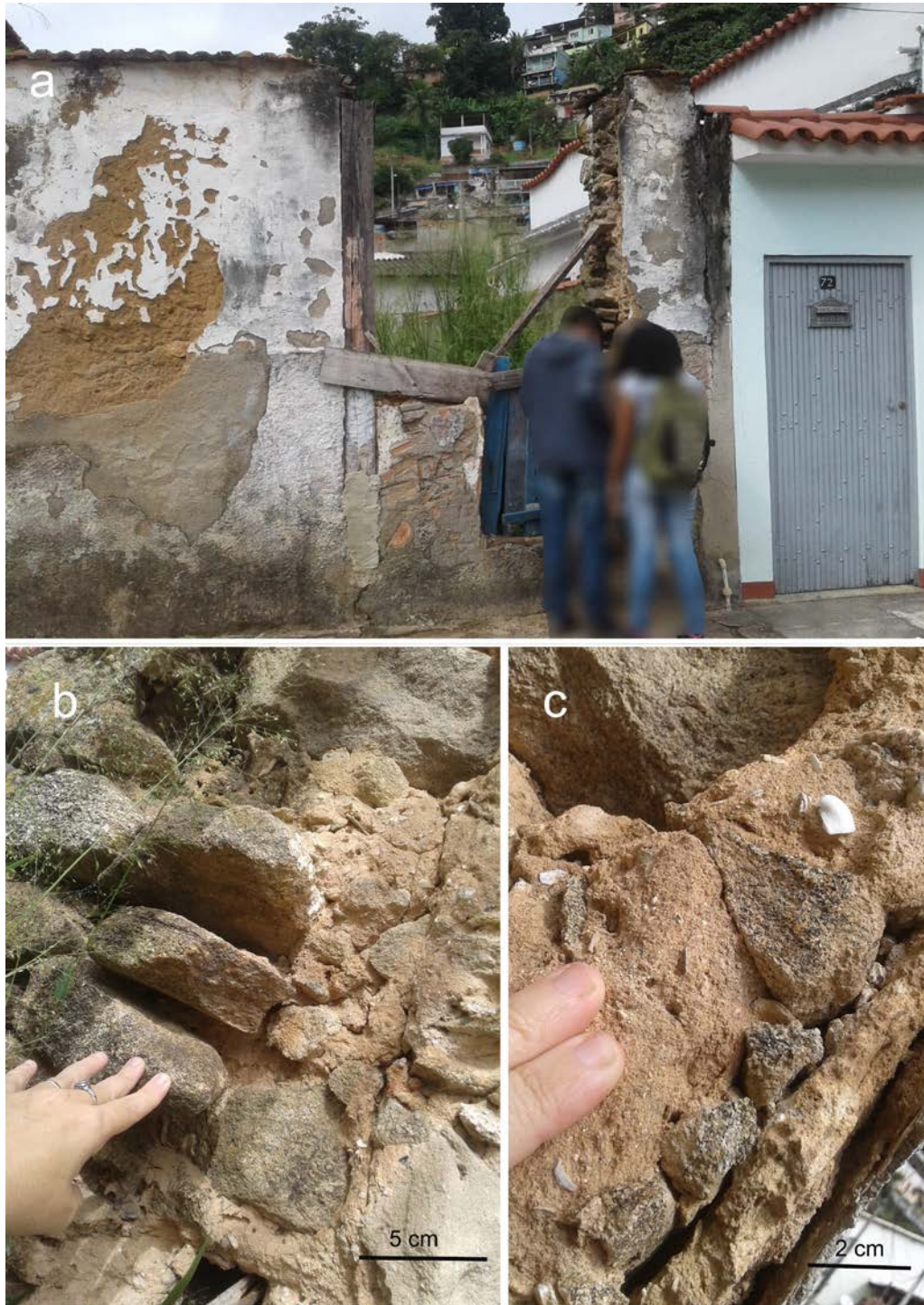
Figura 6. Ruínas de casa de pedra e cal. (a) Vista geral da construção; (b) detalhe dos blocos de granito; (c) conchas em argamassa do revestimento (Fonte: fotografias do autor).
