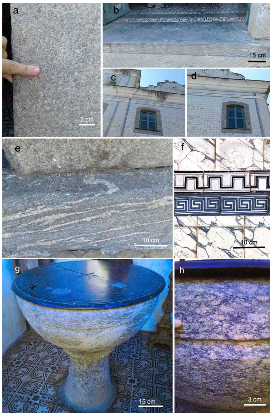
Figura 3. Igreja Nossa Senhora da Guia. (a) granito do portal principal, (b) soleira em gnaiss migmatítico, (c) e (d) janelas com molduras em granito de granulação grossa (e) contraste entre granito (portal) e gnaiss (soleira), (f) estampilha simulando alvenaria de pedra, (g) e (h) pia batismal em gnaiss porfiroclástico (Fonte: fotografias do autor).
