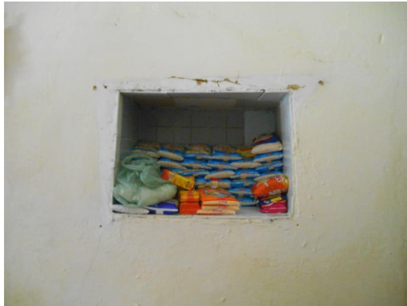
Figura 12. Abertura encontrada dentro de um dos aposentos (sem escada) na casa da Fazenda Brejo de Baixo. Fonte: Laiane Pereira (2017).
