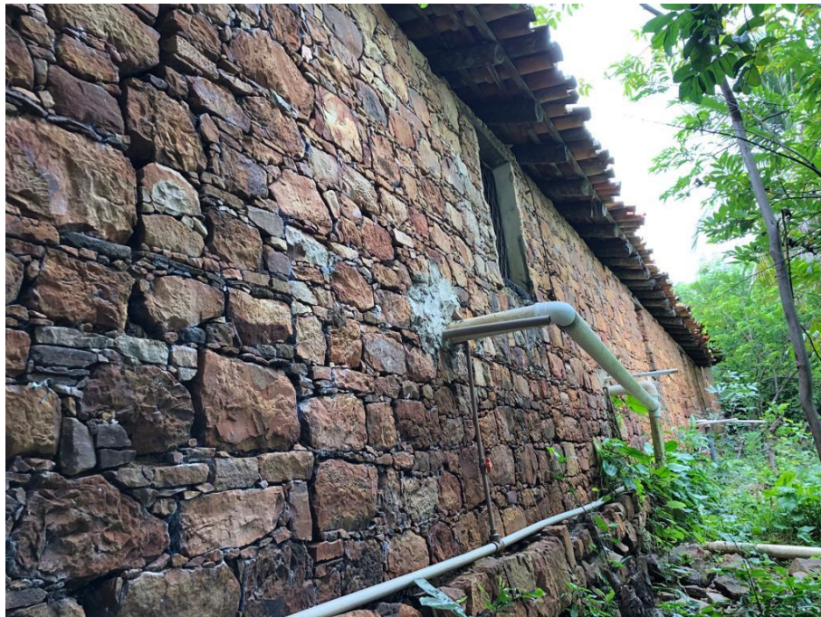
Figura 8. Parede Lateral de pedra e barro. Fazenda Brejo de Baixo. Fonte: Carvalho (2021).
