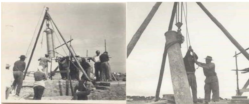
Figura 1. Processo de movimentação dos pilares do templo de Miróbriga para a localização atual. Fonte: Barata (2023). 5
